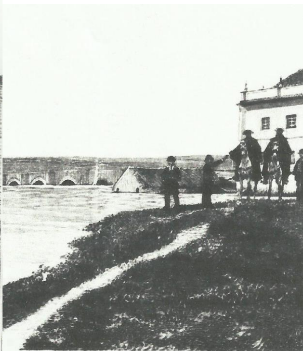
PUENTE Y MOLINOS HARINEROS, VISTOS DESDE LA ORILLA IZQUIERDA DEL RÍO.
